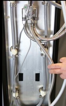
**Etape 7** — Fixer le clips le long du bord de la colonne. Câbles afin de maintenir proprement les fils le long de la colonne.
