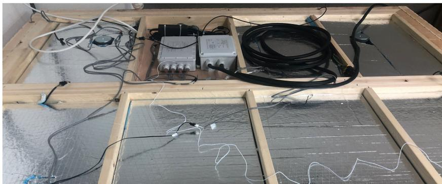
• **Connexion de la lampe :** Passer le câble de la lampe par le trou du panneau latéral pour accéder au toit. Le raccorder ensuite au câble possédant l'étiquette de repérage ci-contre :
