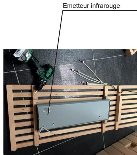
7 Positionner les supports de bancs dans les glissières et brancher les émetteurs infrarouges à l'aide des câbles prévus à cet effet.
